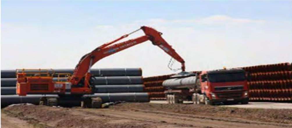
Foto 1. Descarga con vacuna lista (no requiere personal guía con sogá)
