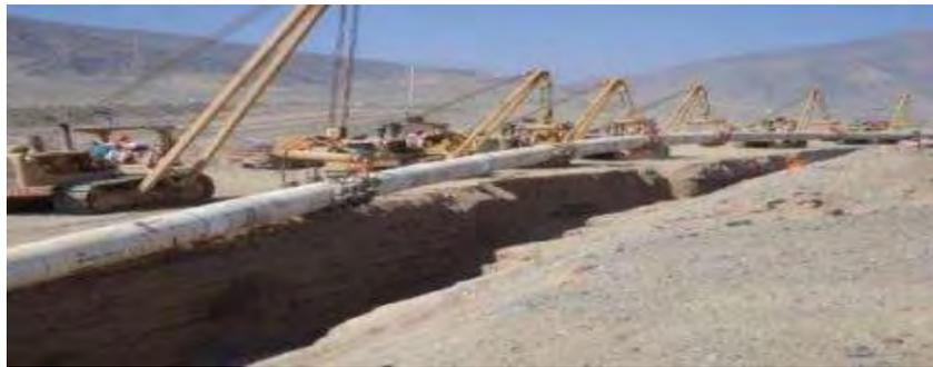
Foto 6. Bajada de tubería mediante sideboon con rollers
