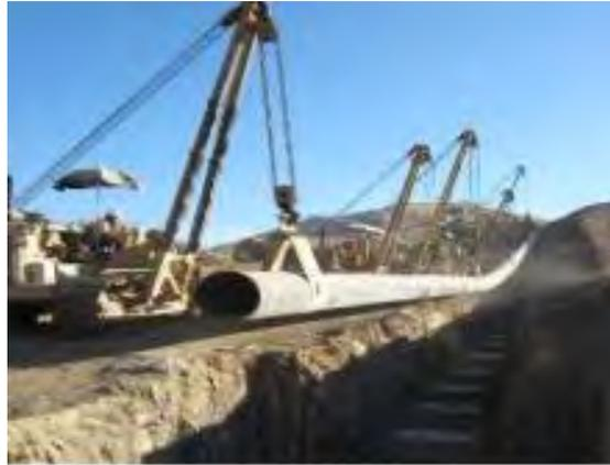
Foto 5. Bajada de Tubería con eslingas redondeadas
